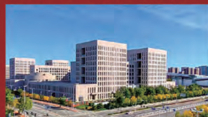
-北京理工大学良乡校区文科组团大楼
